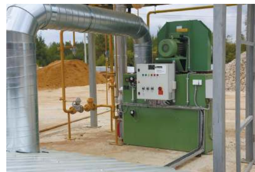
Узел обогрева инертных материалов, Тека
