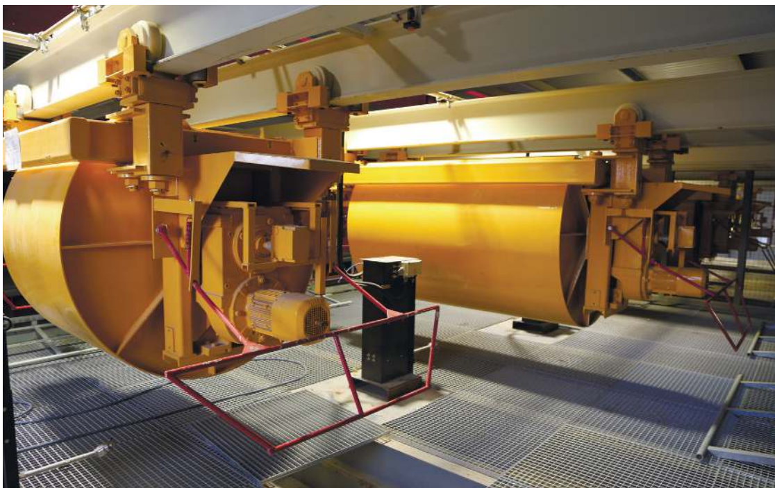
Подача бетона от каждого из пяти миксеров к бетонораздатчикам осуществляется системой адресной подачи
