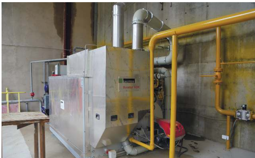
Отопительная установка Buster 1000, Sauter
