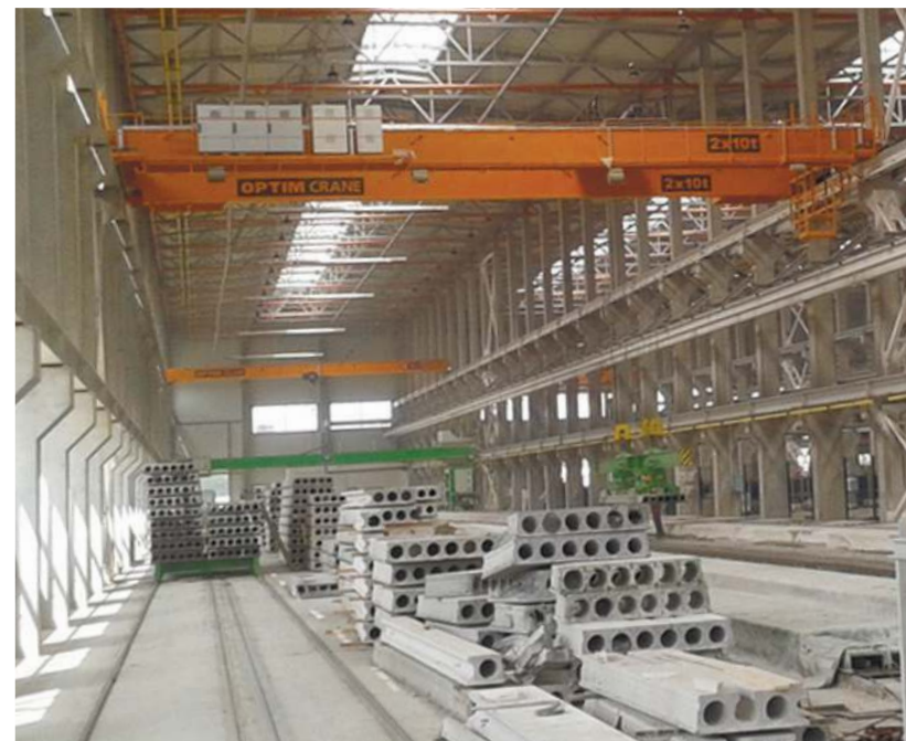
Кран для съема пустотных перекрытий имеет два синхронных подъема по 10 тонн
