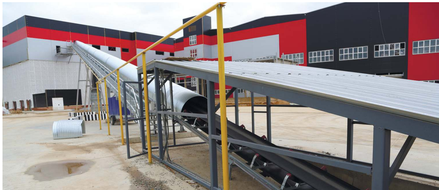
Транспортер подачи инертных материалов на теплый склад, Тека
