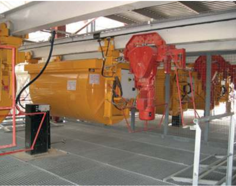
Die Betonversorgung der Fertigungshallen erfolgt über 6 Kübelbahnen von Dudik
