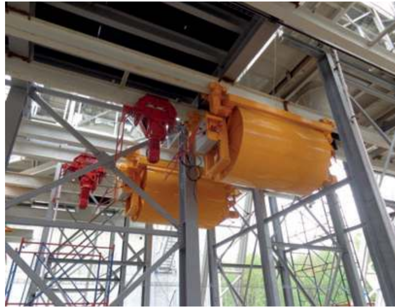
Die Gesamtstrecke der 6 Kübelbahnen beträgt 1.600 m
