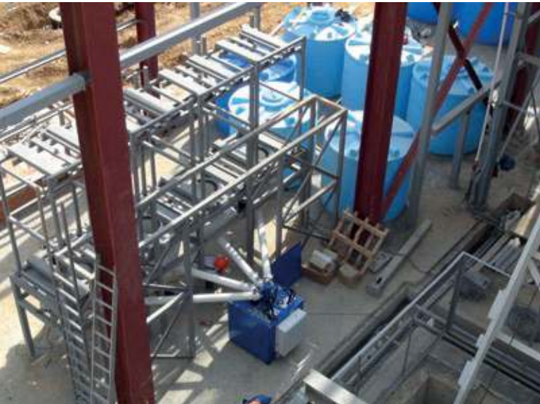
Vollautomatische Farbdosierung Type TFW von Würschum bei der Montage
