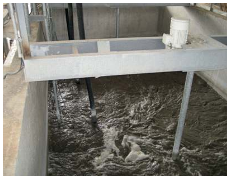
Rührwerke im Rührwerksbecken des Recyclingsystems von Bibko
