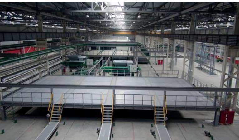
Umlaufanlage mit Vorbereitung für Sandwichwand-Produktion
