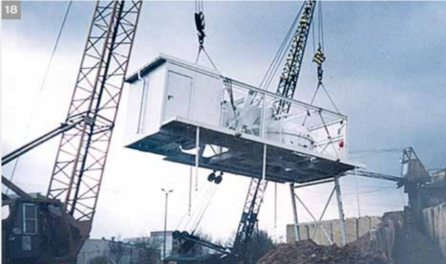
18-22 | Montage MIXOMAT THZ 3000 C 1-R mit TEKA Hochleistungs-Ringtrommischer, separate Mischer- und Waagenbühne als Module und komplette Verkleidung.
