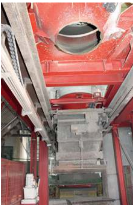
Die Kübelbahn übernimmt dann den Betontransport zu den beiden Brettfertigern.
