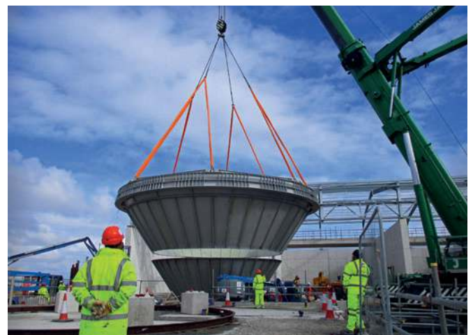
Bau des Grundkegels für das Hüttensandmehl-Silo (April 2017). (Bild: EDF Energy 2017)
