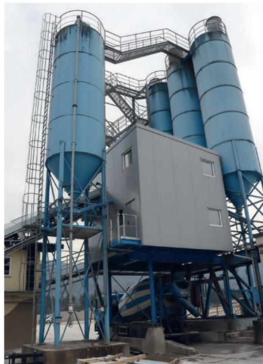
Die Mischstation musste unter beengten Verhältnissen zwischen die vorhandenen Bindemittelsilos aufgebaut werden.
